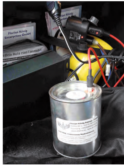
Bild 5: Installation eines großen Pkw-MHR im Kofferraum an der Subwoofer-AMP-Stromversorgung der 12-Volt-DC-Versorgung.
