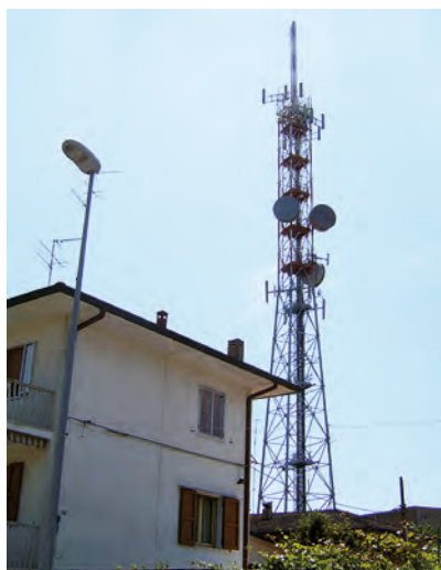
Bild 1: Der Mobilfunkmast für Richtfunk- und Marine-Radar in Porto Garibaldi (Italien) am Mittelmeer
