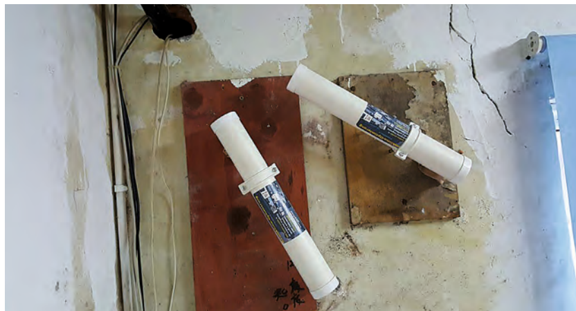
Bild 7: Anbringung zweier MHRs peilend auf eine Hausstromversorgung in einer Chinesischen Offset-/Digital-Druckerei
